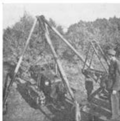
Tung bärgningsbil (lyftkraft 10 ton) i arbete med bandtraktor
